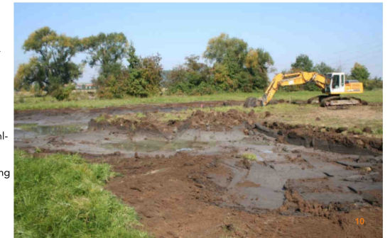
Baggerarbeiten beim Ausheben eines Flachwasserteichs 2009.
